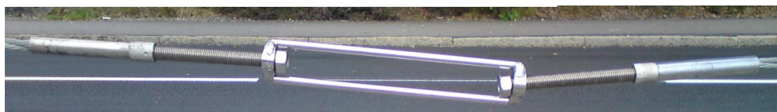
Figur 4. Montera uppspänningspanelen över den avkapade sträckan.
